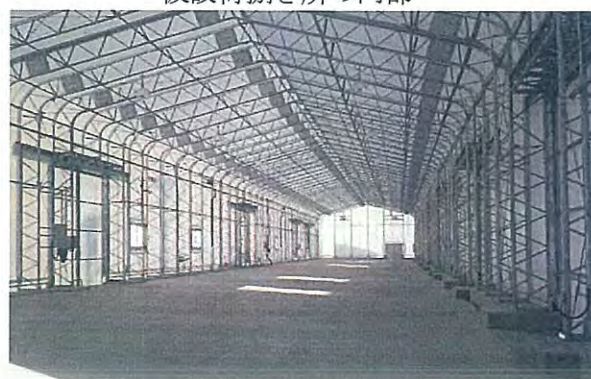
仮設荷捌き所の内部
