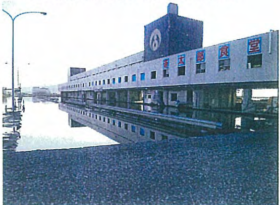
石巻魚市場正面の地盤沈下の影響
