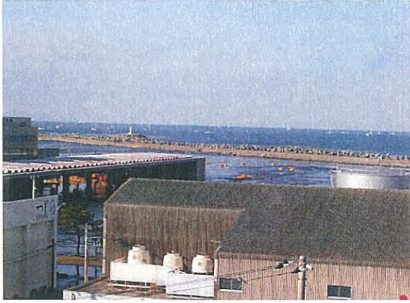
・第3市場のスカイタンクが津波により流失
