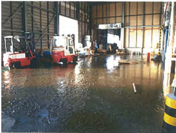
1 冷凍・冷蔵施設 (海水に浸かる)
