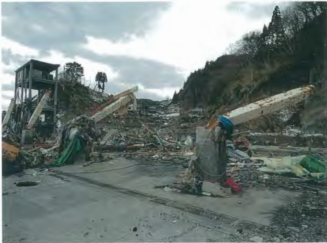
田野畑魚市場の支柱を残し、2階漁協事務所は完全流失
