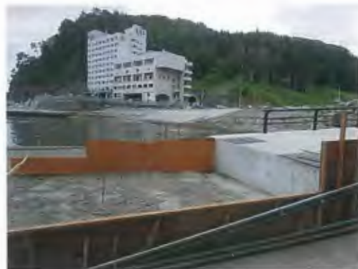
羅賀漁港の復旧工事
