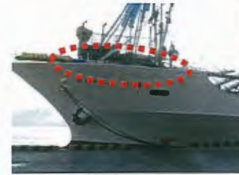
船首甲板上にサイド ローラーを設置
