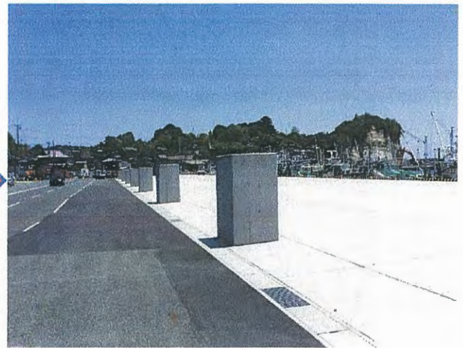
⑤陸電施設(完了)
