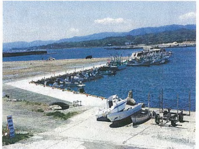
⑥大津港東部地区(完了)
