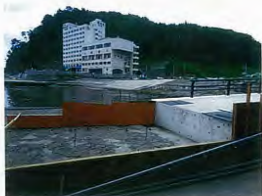
羅賀漁港の復旧工事
