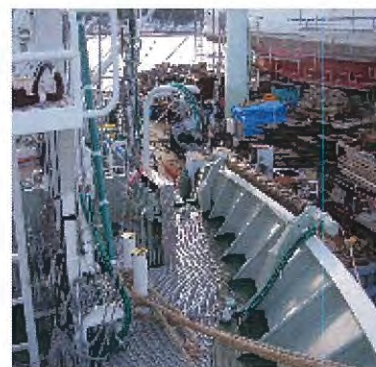
船首甲板上にサイド ローラーを設置
