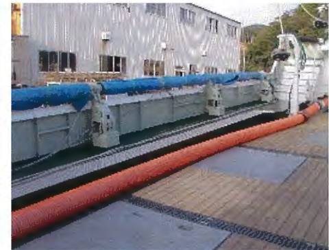
上甲板上にミニポールローラー(網捌機)を設置
