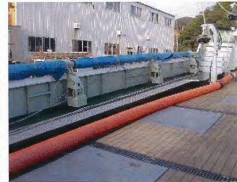
上甲板上にミニボールロー ラー(網捌機)を設置
