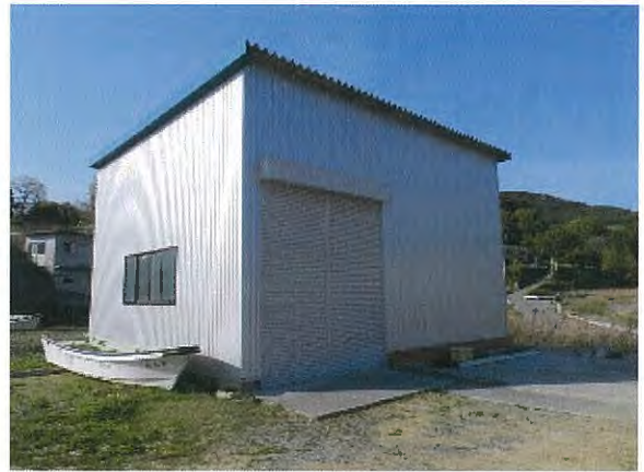
修繕後（自力再建した漁具資材倉庫）
