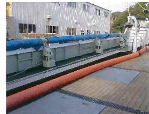
上甲板上にミニポールロー ラー(網捌機)を設置
