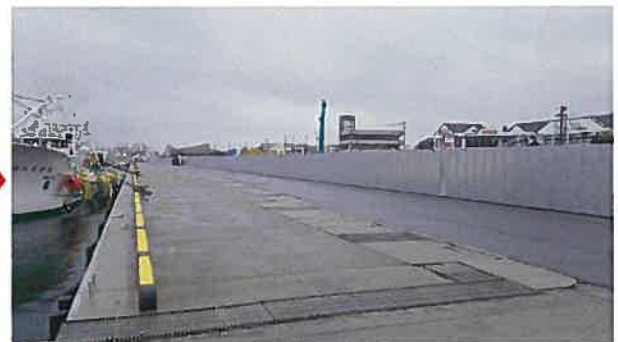
※小名浜魚市場(栄町、コンクリート建物)は、現在解体作業中。
