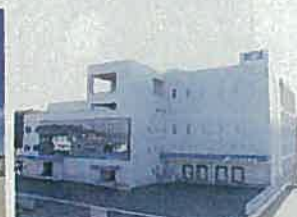
近接する冷凍冷蔵施設
