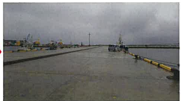
※岸壁の修復完了
