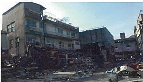
震災後の事務所（有限会社本田漁業部）
