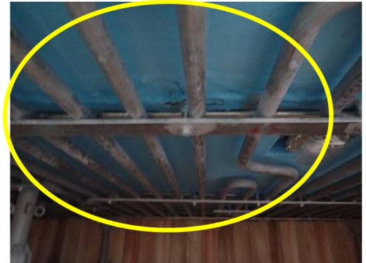
魚艙内壁のFRP仕様
