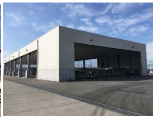
冷凍荷捌き施設
