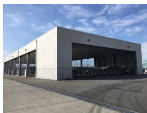
冷凍荷捌き施設
