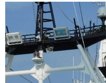
カメラの設置
