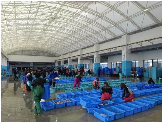
復旧した相馬原釜地方卸売市場
