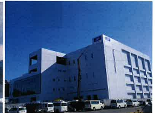
冷凍施設(平成27年3月)
