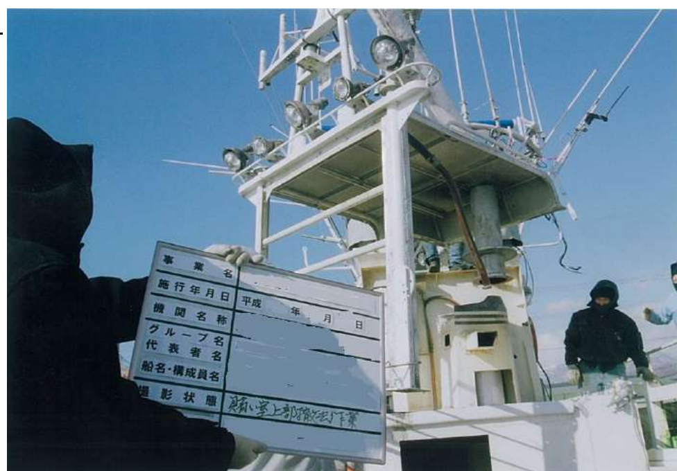
写真3 機関室上部撤去作業
