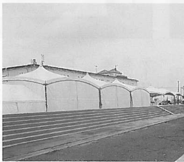
整備された堤防
