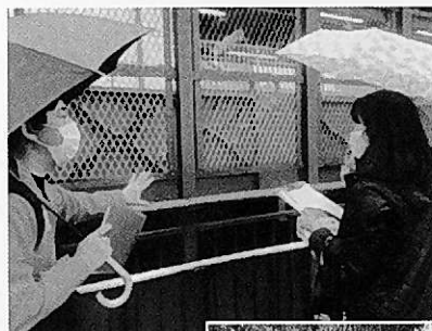
◀ JR三ノ宮高架の機銃掃射跡
