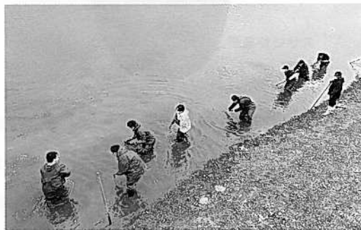
人力による泥の掻き出し
