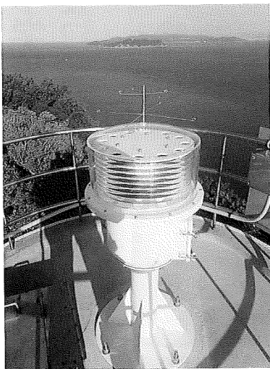
新たに設置されたLED灯器 背後は友ヶ島水道
