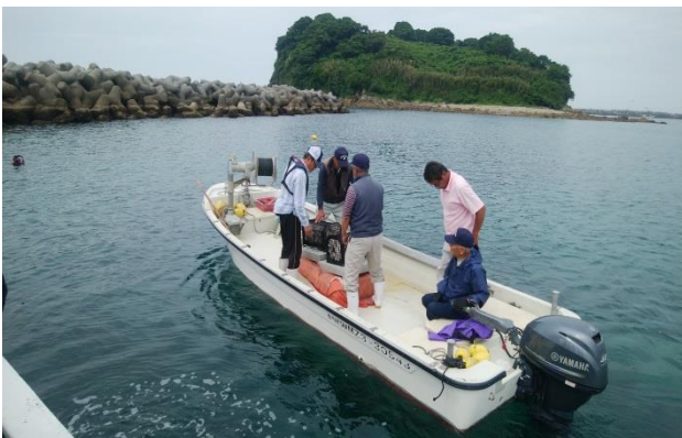
作業船へ積み込み、設置準備
